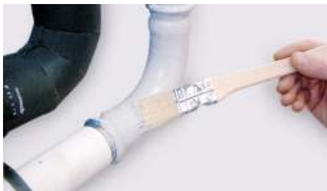
Рис. 37. Покраска соединений и труб праймером.
